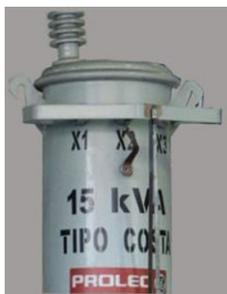
Transformador tipo poste de 15 KVA trifásico de 3 boquillas con un voltaje de operación primaria de 34,500 volts y un voltaje secundario de 220/127 volts 3 fases conexión en estrella, operación radial.
