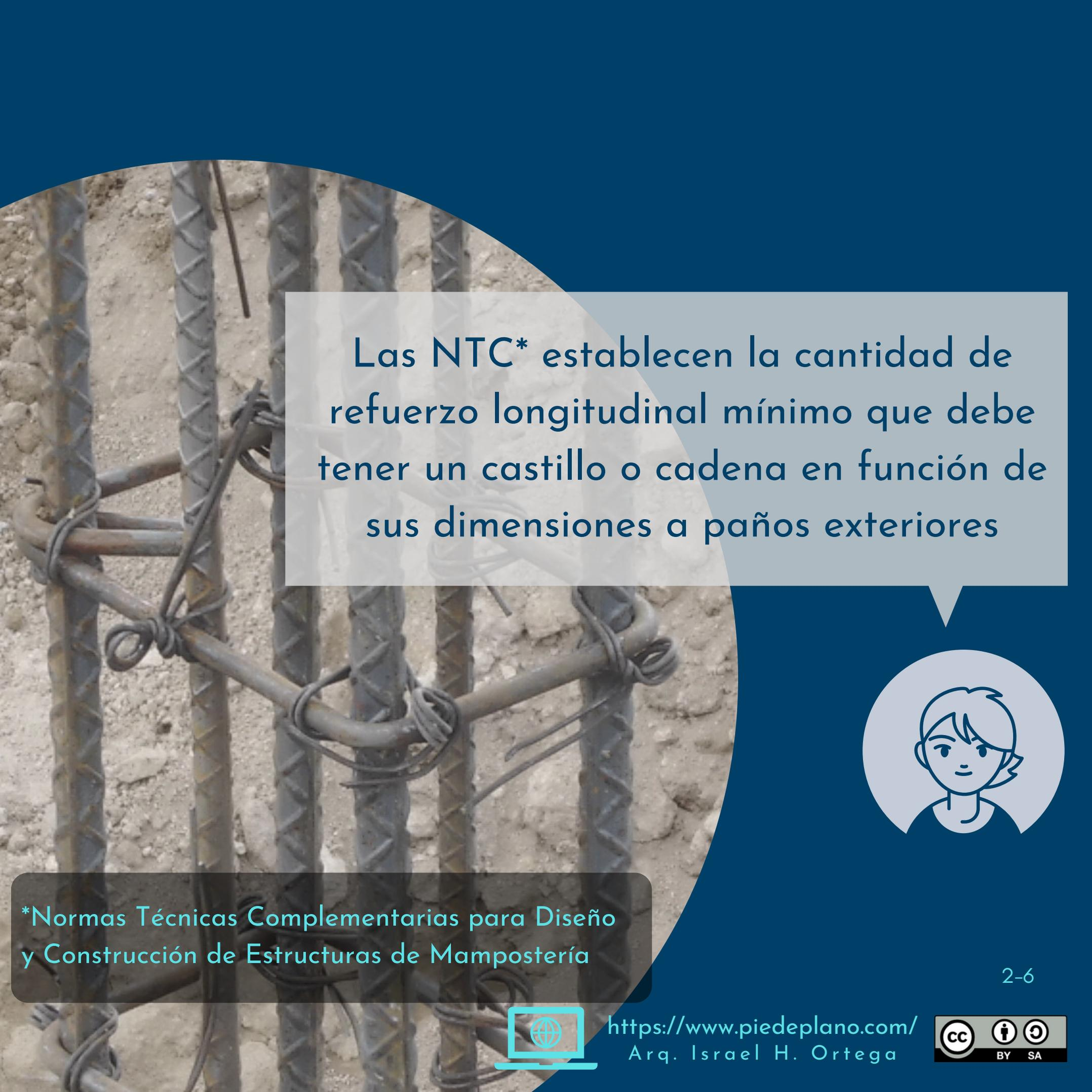
Las NTC\* establecen la cantidad de refuerzo longitudinal mínimo que debe tener un castillo o cadena en función de sus dimensiones a paños exteriores
